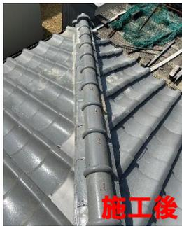
瓦葺き屋根の雨漏りのご相談です。調査したところ、瓦のズレでした。棟瓦がずれ、割れている箇所もあり、漆喰もボロボロになっていました。この部分から雨が入り、雨漏りが起こっていました。昔の瓦葺き屋根は、屋根に土を盛り、その上に瓦を載せただけの状態でした。もちろん下地が土なので、地震や強風で瓦がズれてしまいますし、年月が経つにつれ、土がゆるくなり、少しずつ瓦がズれてきてしまうのです。こちらのお家も経年で棟瓦も全体的にズレ、雨漏りの原因となったようです。棟瓦を全て取り除いたところ、下の土は水がしみて湿っていました！今回、土は取り除き漆喰で施工し、新たに瓦を葺きなおしました。大切なお家、メンテナンスをして長く住んでいただきたいです。早めに修理すると、大がかりな工事になりませんので、安価で済ませることができます。遅くとも築30年以上になりましたら、1～2年に1度の屋根点検をおススメします！
