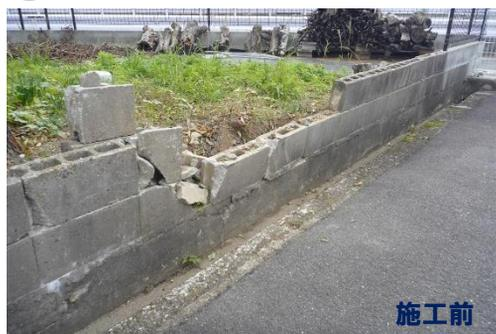
お家のブロック塀に車が当たって破損。補修工事をさせていただきました。当たった衝撃で全体的に傾いていましたので、全面改修させていただきました。
